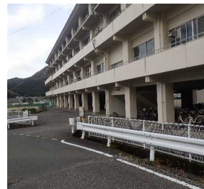
ピロティ構造による浸水対策
