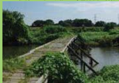
ピオトープの整備
