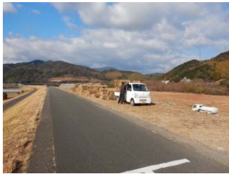
③ 北岸堰南側の堤防上 (阿南市上大野町北豊年地先)
