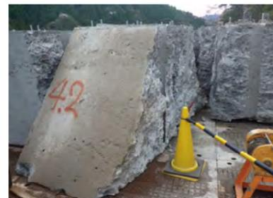
◀既設堤体から切り取ったコンクリート塊です。1つの塊が5.6t以下の重さになるように切り出しています。（高さ約1.5m）
