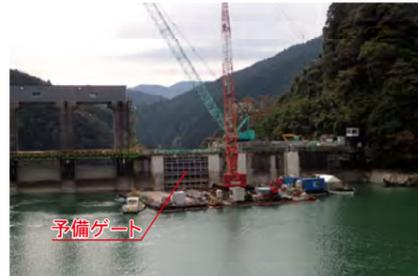
▲予備ゲート設置後にダム堤体切削を実施するため、貯水池の水を下げずに施工できます。
