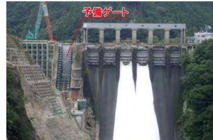
▲ダム堤体切削中も洪水調節のための放流が可能です。
