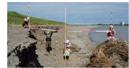
▲洪水による局所洗掘状況
