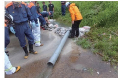
▲水防団による漏水対策状況
