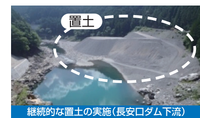
継続的な置土の実施(長安口ダム下流)
