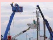
配電線復旧訓練
