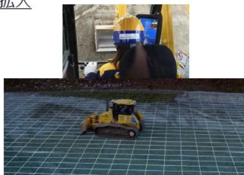
ICT建機による施工
