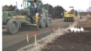
丁張りによる施工
