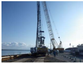
堤防耐震工事状況
