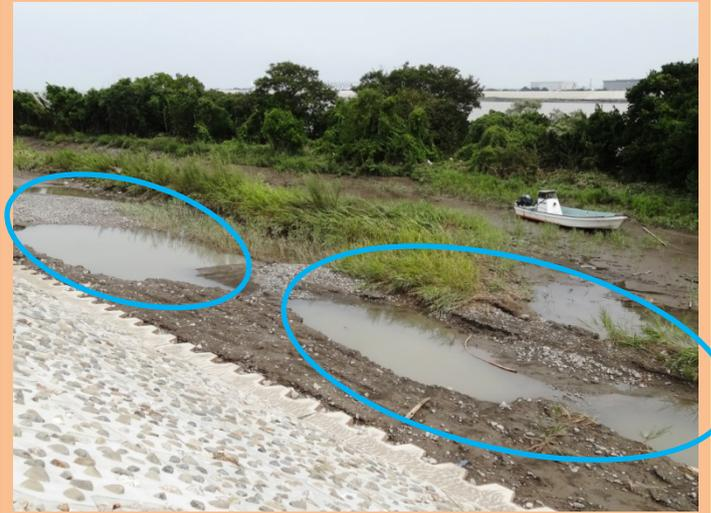
根固めブロック上にシルト質土を埋め戻した箇所
