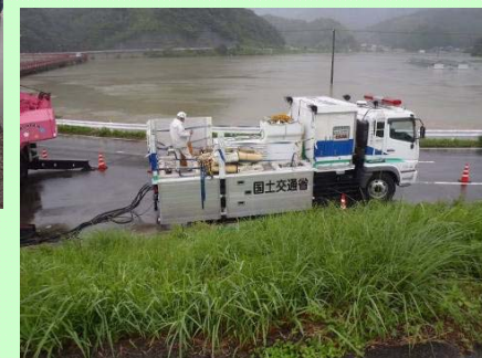
▲排水ポンプ車排水状況(那賀川右岸13.8km付近)
