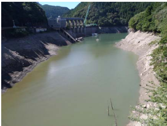
長安ロダム貯水池周辺
