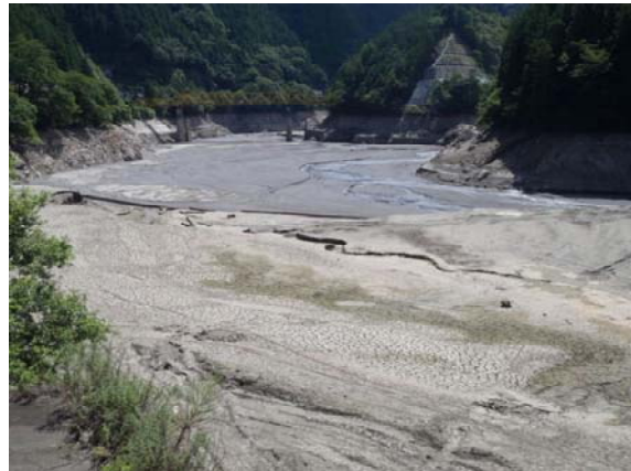
出合橋より上流付近
