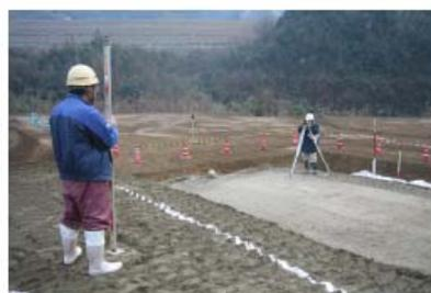
沈下量測定
