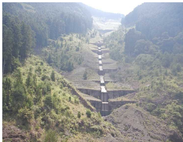
阿津江崩壊地跡
