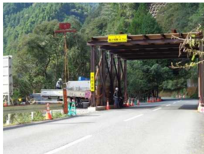
【道路防護柵（国道195号上）】 【ケーブルネット（国道195号・河川上）】 【仮設構台（国道195号沿）】
