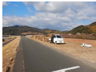
④北岸堰南側の堤防上 (阿南市上大野町北豊年地先)
