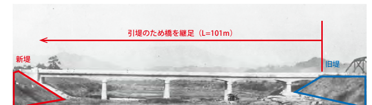
北側は 4 径間の曲弦ワーレントラス橋（235.91m）、南側はコンクリート桁橋（101m）が架かっており、トラス部は昭和 3 年に吉野川橋と同じく増田淳氏の設計により架けられました。コンクリート部分は引堤により継ぎ足されたもので昭和 17 年に完成しました。
