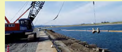
根固めブロックの設置状況
