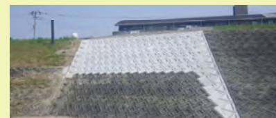
護岸の補修状況
