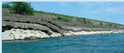
局所洗掘による被災の状況
