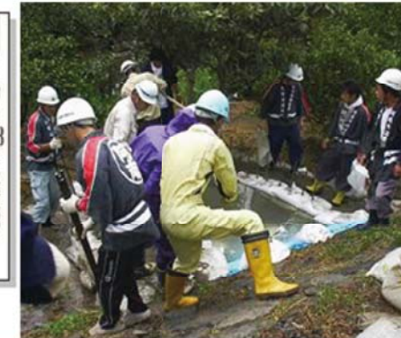
上大野地区 月の輪工実施写真 (H16台風10号)
