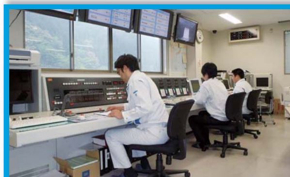
長安口ダム操作室
