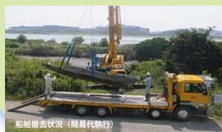
船舶撤去状況(簡易代航行)
