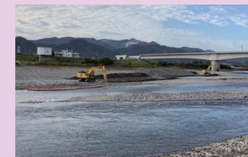
河道掘削の実施状況写真
