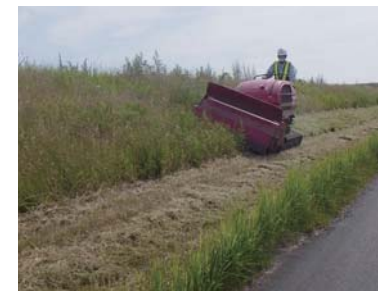
堤防除草状況
