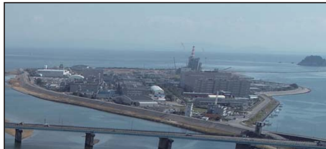
辰巳新田 1835年から横見町の新兵衛という人物により新田開発が始まり、資金不足により1843年に小松島の豪商鹿島屋（井上屋）に権利が譲渡され、明治時代まで開発が行われました。度重なる洪水や地震の度に修復を重ね、昭和20年代に入って大部分が完成し、現在は工業団地となっています。
