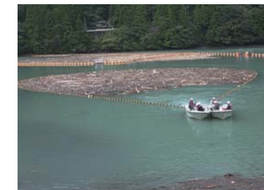
貯水池内の流木処理状況
