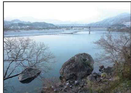
古毛の水兎岩 （通称：大岩） 弘化2（1845）年に吉田宅兵衛の孫が北岸硯石山より巨大な石を掘り出して落とし「水兎岩」を築きました。これは勢いの強い流水が、直接堤防に当たらないようにする水制の役割をさせたものでした。
