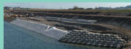
下大野地区堤防工事の状況写真
