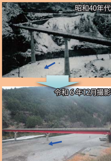
貯水池(助大橋付近)堆砂状況
