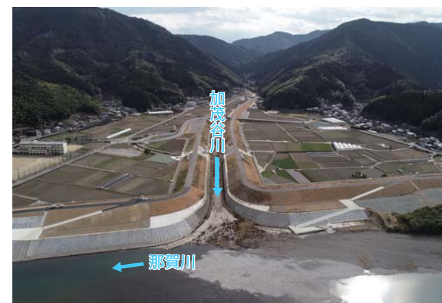
加茂堤防完成写真
