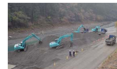
▲堆砂除去状況(追立ダム上流箇所)
