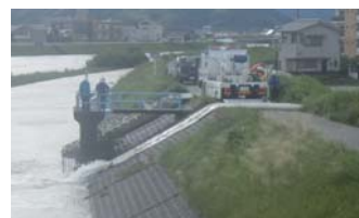
排水ポンプ車による排水状況
