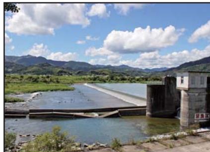
広瀬用水と北岸堰 明和9（1772）年から佐藤良左衛門の孫が18年の歳月をかけ自身の命と引き替えに用水の水が十分に届かなかった中庄方面への用水の開削を行いました。現在の北岸用水の上流部分はほぼ広瀬用水を転用しています。令和5年度に北岸堰は撤去され、床止めになっています。
