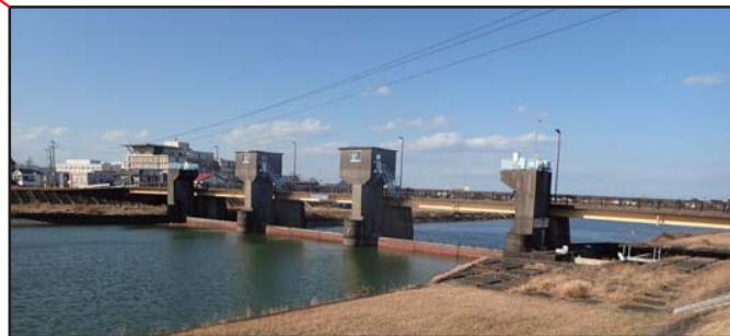
一の堰 現在の一の堰は三代目です。一代目は1638年に作られましたが、1946年の南海地震と台風により一部が崩壊し、1953年に二代目が下流に改築されました。現在の一の堰は1968年に完成し、富岡町、見能林、才見町などに灌漑用水を供給しています。
