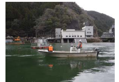
貯水池巡視状況
