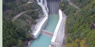
堤防事業が完成した那賀町の中心 和食地区
