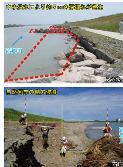
那賀川は、川幅が狭い影響などにより、洪水時の水位が高くなりやすい傾向があります。また、堤防は旧河道上につくられている箇所が多く、川砂利で造られているため、漏水が頻発する状況にあります。
