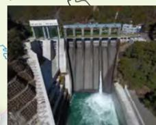
新設洪水吐ゲート完成の長安口ダム
