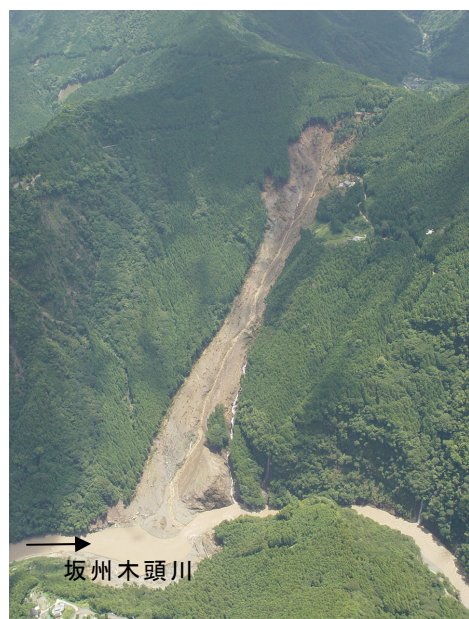
那賀町阿津江地区の地すべり状況
