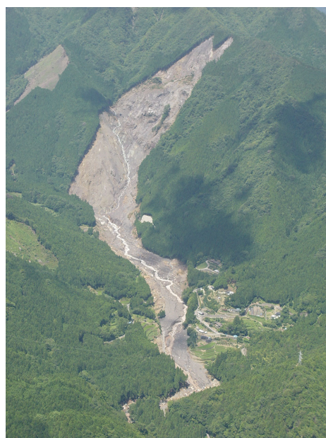
那賀町大用知地区の地すべり状況
