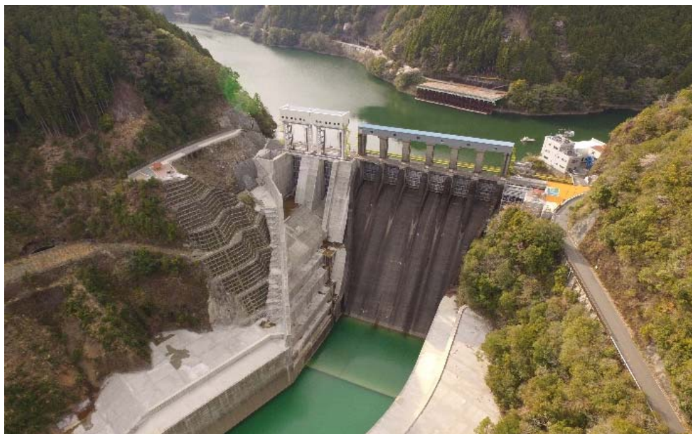
長安口ダム上空写真
