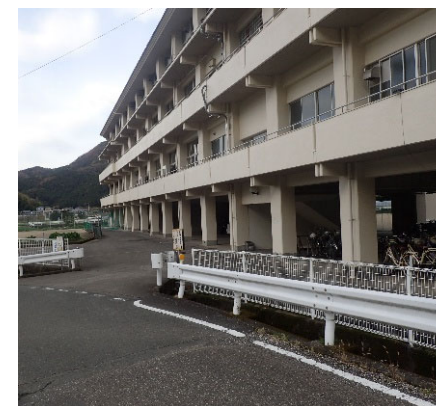
ピロティ構造による浸水対策
