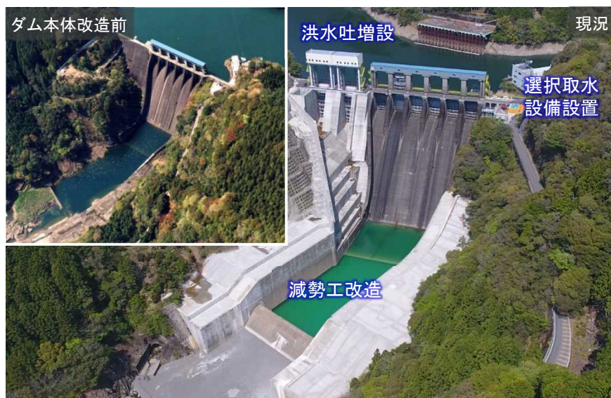
長安口ダム改造事業(ダム本体改造)
