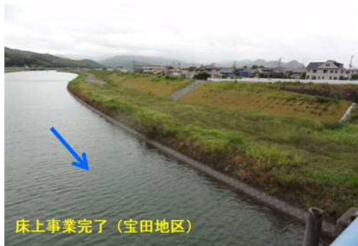
図 2.30 床上浸水対策特別緊急事業完成（引堤）
