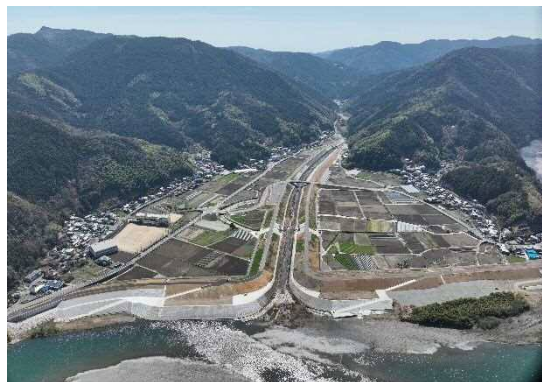
図 2.33 那賀川床上浸水対策特別緊急事業（加茂地区）
