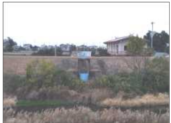
岡川左岸3号樋門
