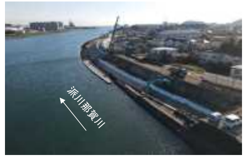
樋門本体工実施状況 (R8年1月撮影)
