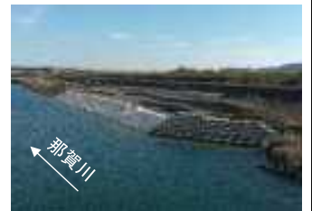
施工中 (R7年12月撮影)
