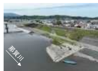
施工前 (R6年7月撮影)
