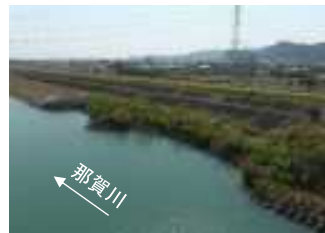
施工前 (R7年4月撮影)
