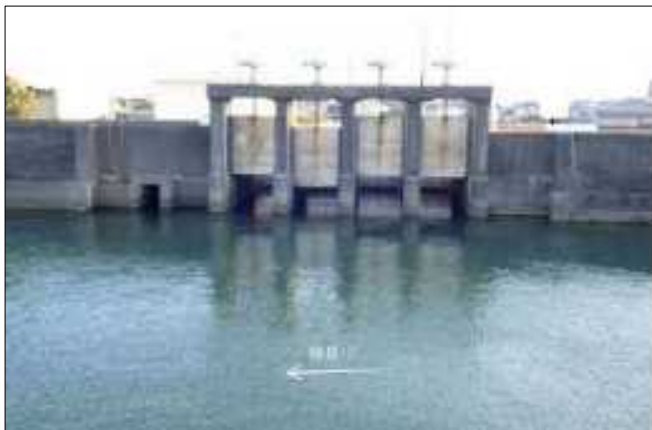
野上排水機場樋門
