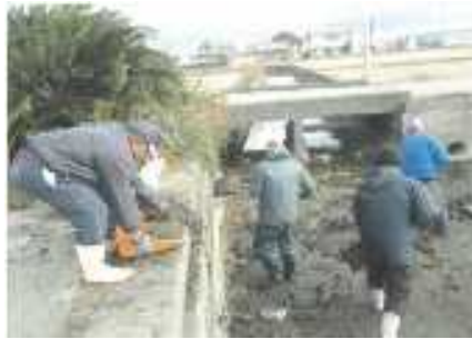
[水路の泥上げ]
