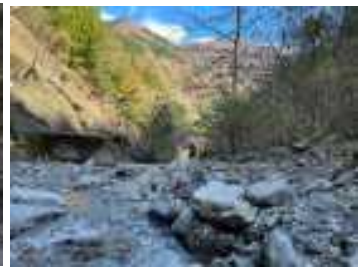
土砂流出を軽減した治山ダム工
