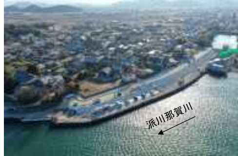
築堤護岸工実施状況 (R8年1月撮影)
