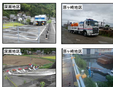
那賀川・派川那賀川(R6.8.28～31) 那賀川河川事務所
