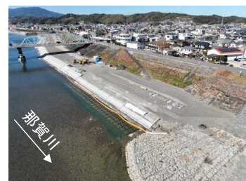
施工中 (R7年1月撮影)
