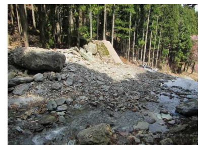
土砂流出を軽減した治山ダム工
