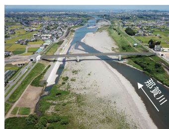
施工前 (R6年5月撮影)
