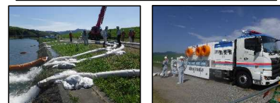
桑野川(R6.6.13) 那賀川河川事務所
