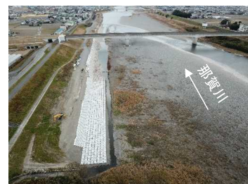
施工中 (R7年1月撮影)
