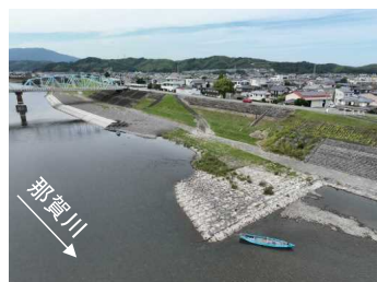
施工前 (R6年7月撮影)
