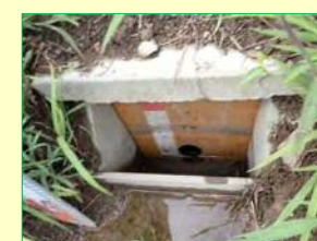
排水調整板の設置
