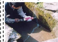
水路のひび割れ補修
