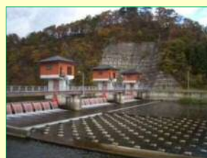
頭首工の管理
