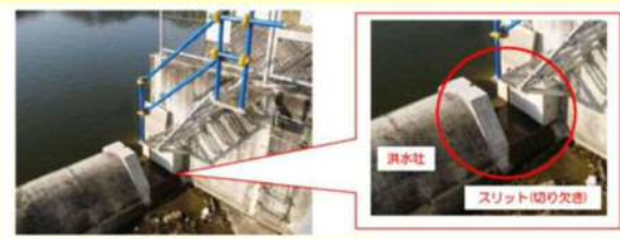
ため池の洪水調節機能を強化するための「洪水吐きスリット」設置状況
