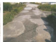
農道の窪みの補修
