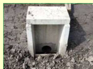
排水口の整備
