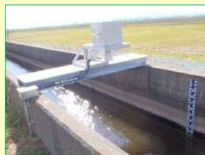
水位計の設置
