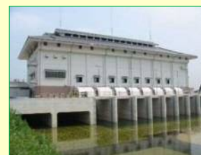
排水機場の管理
