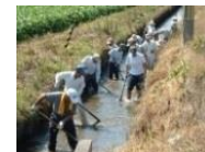
水路の泥上げ
