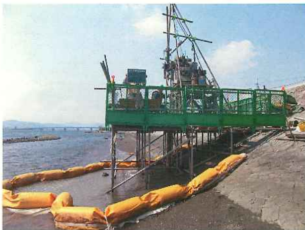
・堤防基盤の地質調査状況写真 (那賀川左岸)
