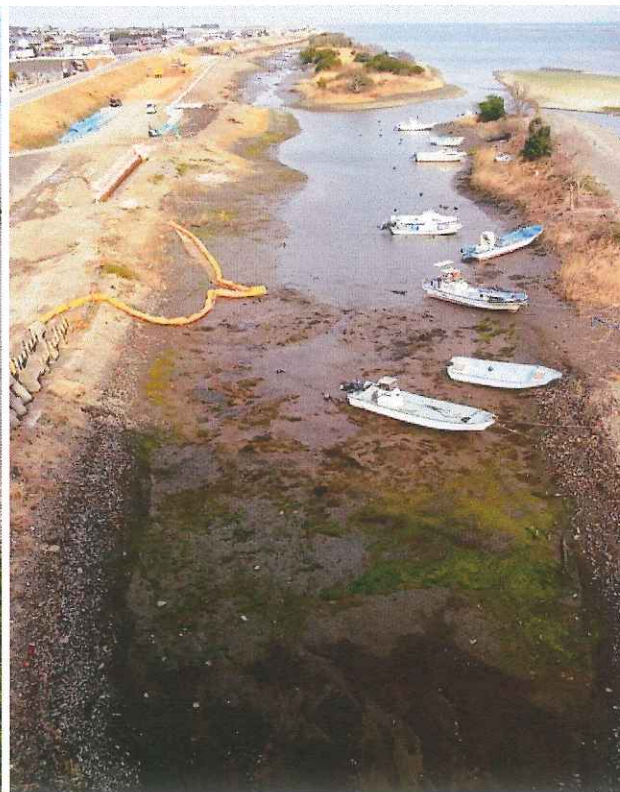
H26年2月19日 工事中の状況
