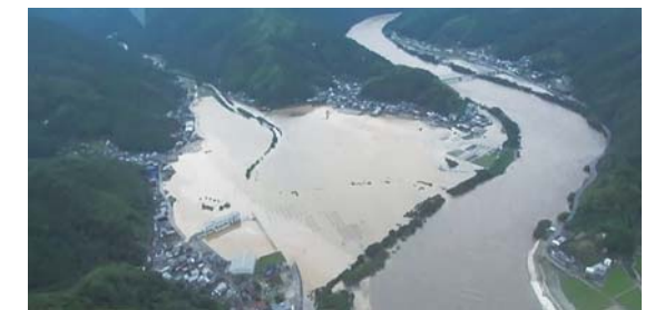
阿南市加茂町加茂地区の浸水状況
