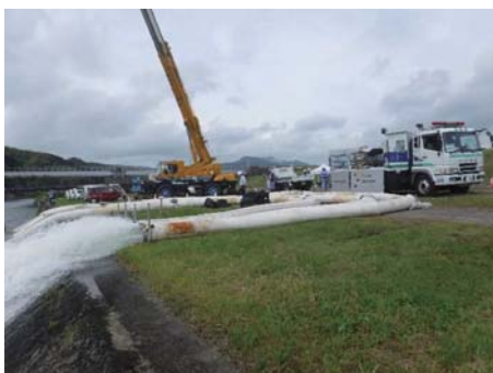
写真-1 排水ポンプ車訓練状況(5月21日)
