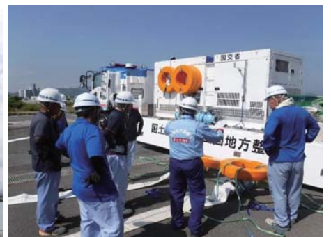
写真-3 排水ポンプ車訓練状況(6月20日)
