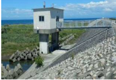
辰巳那賀川樋門
