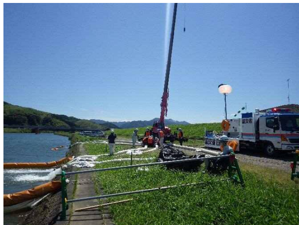
写真-1 排水ポンプ車訓練状況(6月13日)
