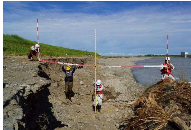
水衝・洗掘箇所の写真(H26年8月)
