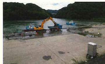
浚渫土の陸揚げ
