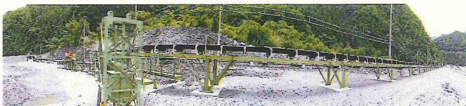
土砂運搬用ベルトコンベア
