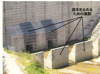
常用洪水吐の状況(ダム上流面)
