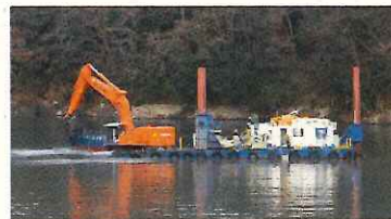
相模ダムのバックホウ浚渫
