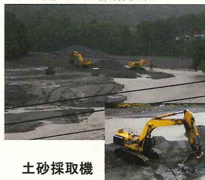
ダム湖内での掘削状況
