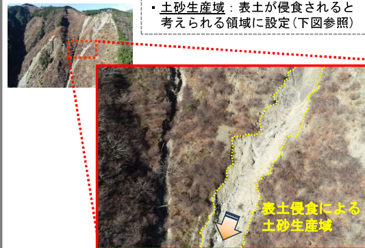
図 2.4 表土侵食による土砂生産の状況
