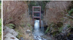
東谷川砂防堰堤 (H24完成)
