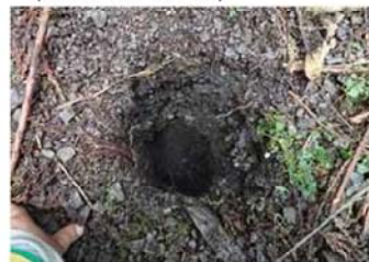
試験孔掘削の状況 (No. 3 R3. 10. 12)
