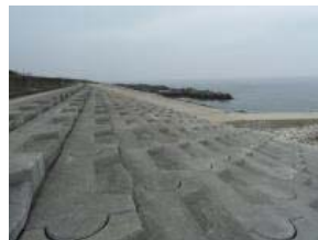
緩傾斜護岸工
