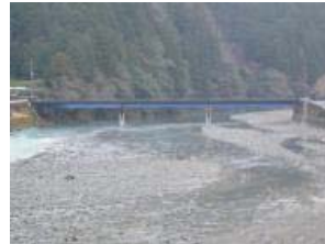
河床掘削 (出原橋下流)
