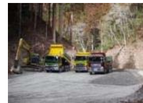
小見野々ダムにおける 山地処理状況
