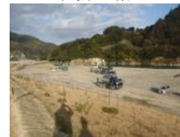
河道の掘削状況
