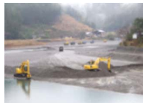
小見野々ダムにおける 陸上掘削状況 (助地区)
