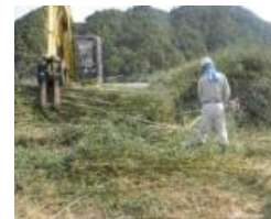
樹木伐採状況(楠根)
