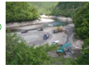
長安ロダム改造事業における 堆砂掘削状況 (平谷箇所)
