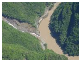
崩壊箇所 (加州、平成16年)
