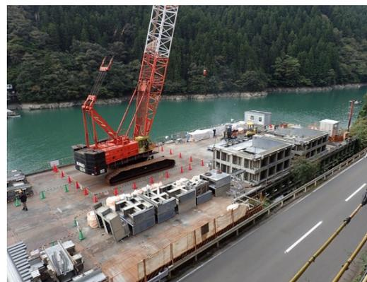
仮締切撤去状況(貯水池構台上)
