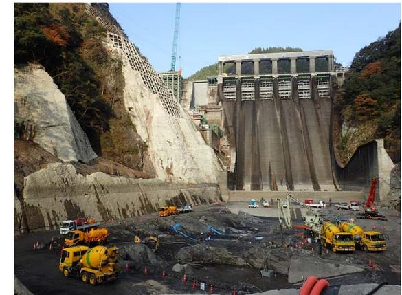
深掘部コンクリート打設状況
