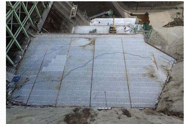
マット部コンクリート施工完了
