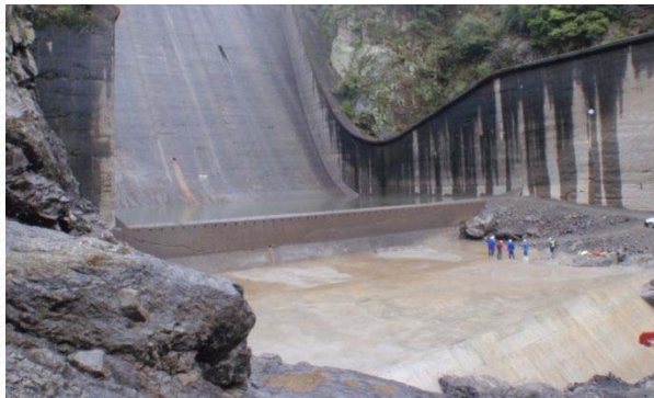
減勢工（穴埋めコンクリート打設） 施工完了（1シーズン目）
