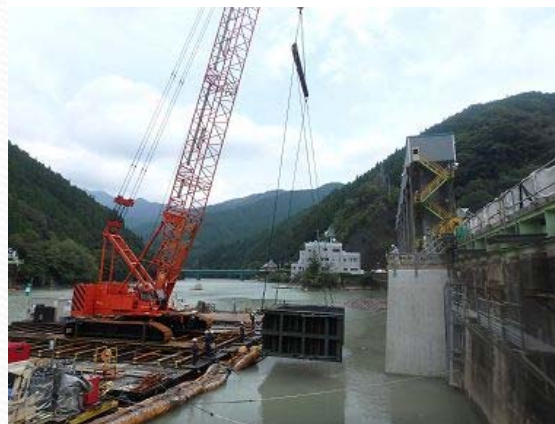
仮締切撤去状況（10BL施工時写真）
