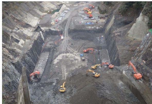
減勢工掘削施工状況
