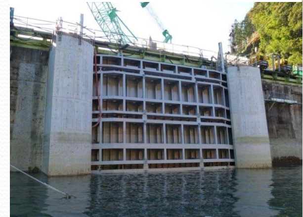
予備ゲート据付状況（10BL）
