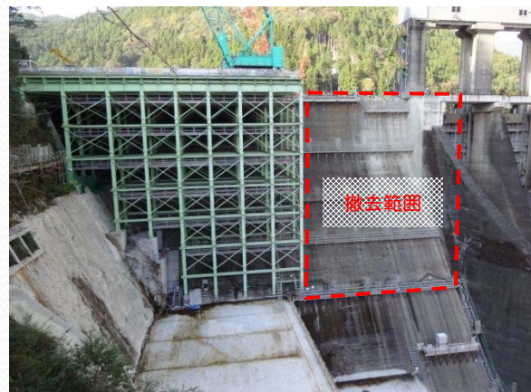
天端仮設構台の撤去完了（10BL）
