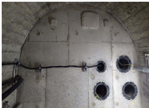
監査廊閉塞工（10BL）施工完了
