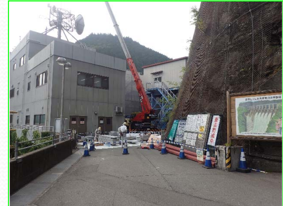
開閉装置上屋付属設備施工状況
