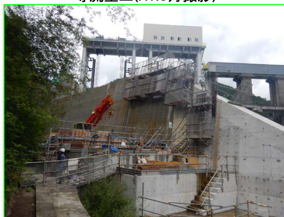
導流壁工(R1.5月撮影)
