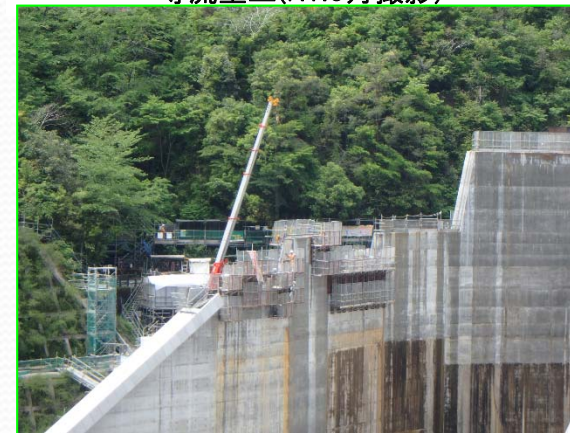
導流壁工(R1.5月撮影)
