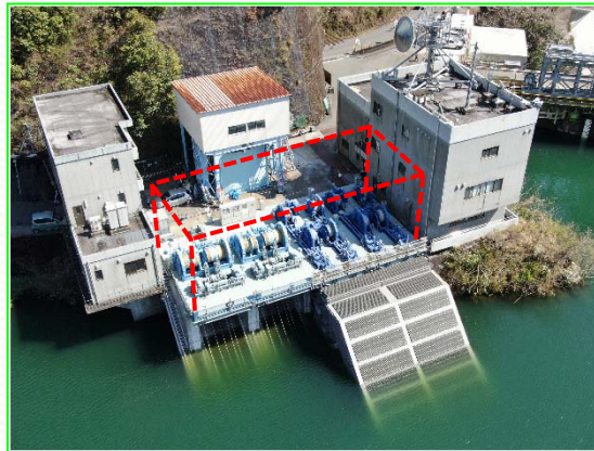
選択取水設備据付完了
