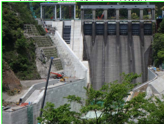
改造工事全景: 下流より(R1.5月撮影)
