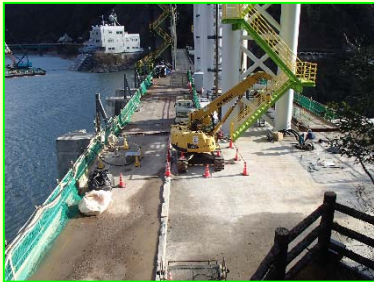
堤体工：施工前状況
