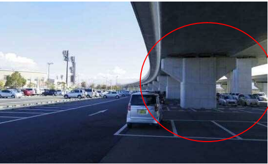
・高架下を公園駐車場として有効利用している既存区間
