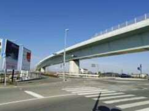
インター線の鋼橋色（G系）
