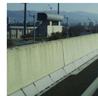
供用済み区間の剛性防護柵
