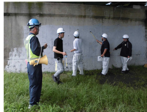
現地実習(打音点検状況)
