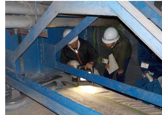
支承防錆工の施工状況見学
