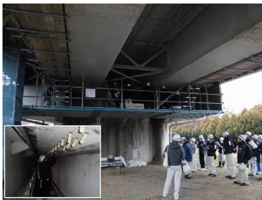
現地実習(床版補修工)
