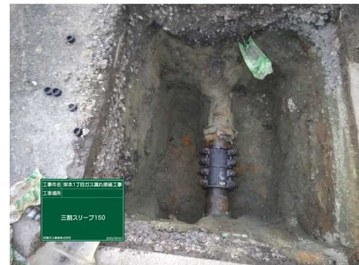
ガス漏えい箇所の修理状況 松山市道(愛媛県松山市)
