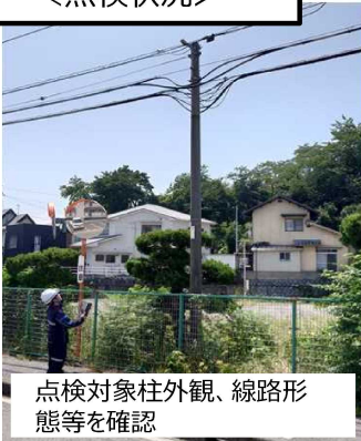
コンクリート柱ひび割れ等 不良有無確認
