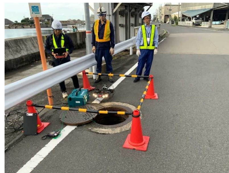
ドローンを用いた管路調査状況（愛媛県四国中央市）
