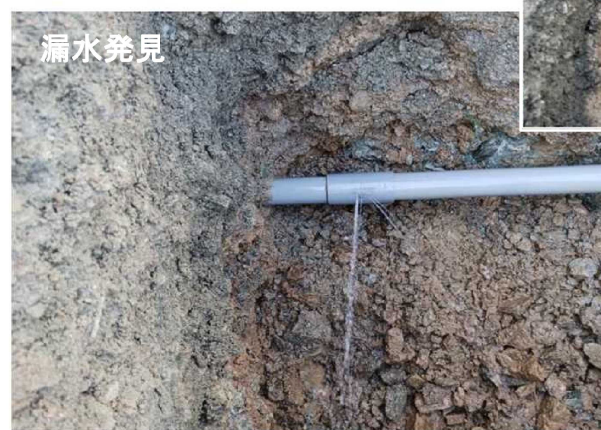
漏水箇所補修(愛媛県内子町)
