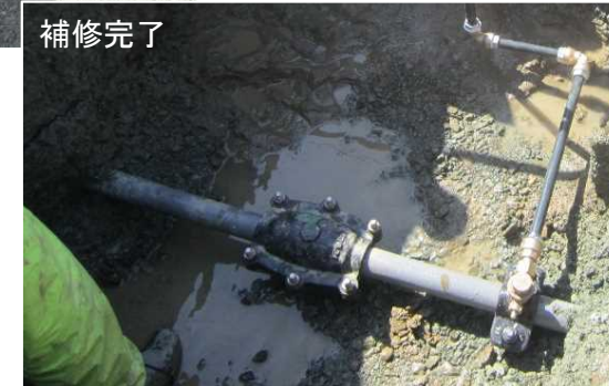
漏水箇所補修（愛媛県宇和島市）
