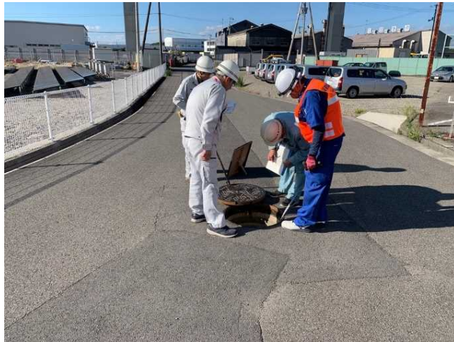
点検状況（愛媛県伊予郡砥部町） ※官民合同現地調査訓練の状況
