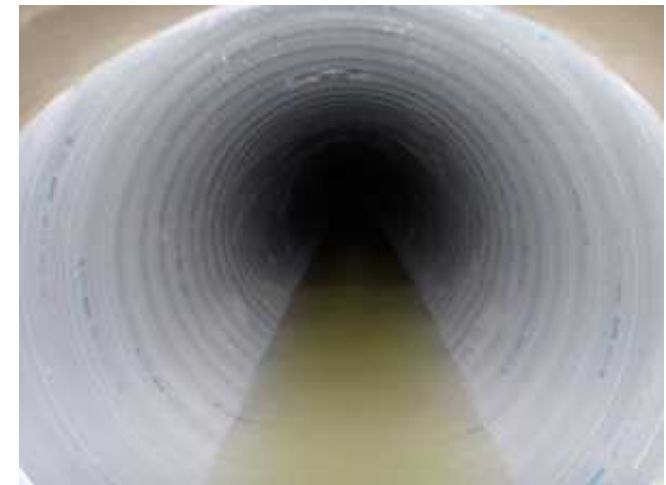
管更生の事例（愛媛県松山市）
