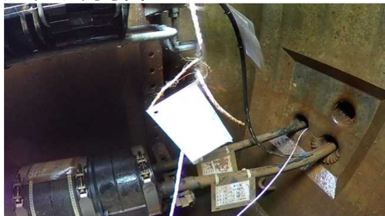
マンホール内写真
