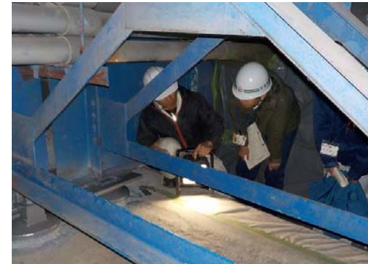
支承防錆工の施工状況見学
