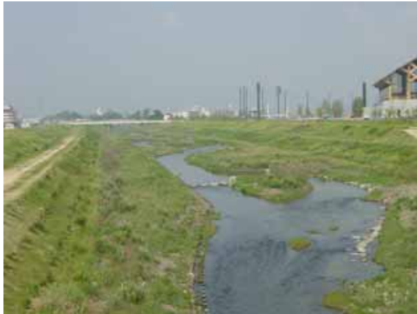
中央公園橋上流
