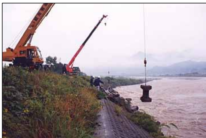
応急復旧活動（平成7年東温市牛淵地先） （重信川 河口より14.6km 付近東温市北側）
