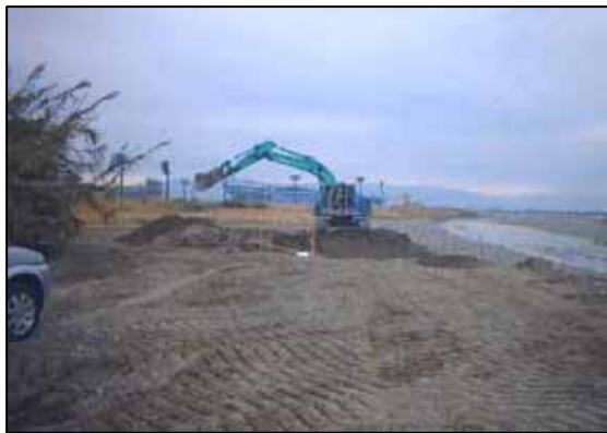
河床整正状況
