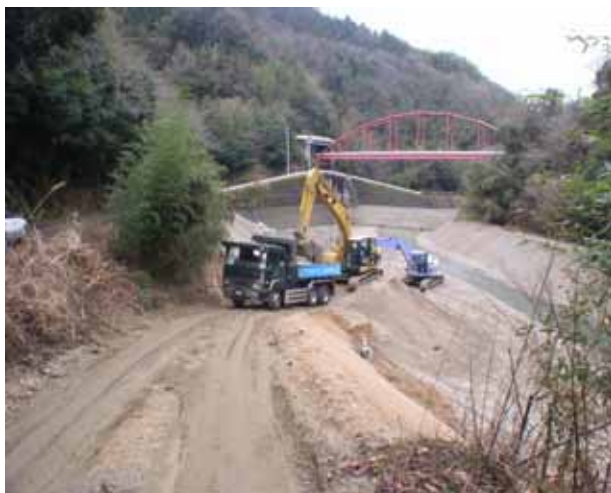
堆砂除去の状況（石手川ダム）
