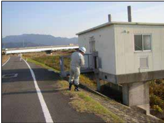
排水門点検状況
