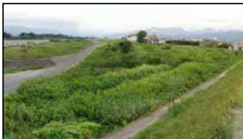
整備前の広瀬霞の様子
