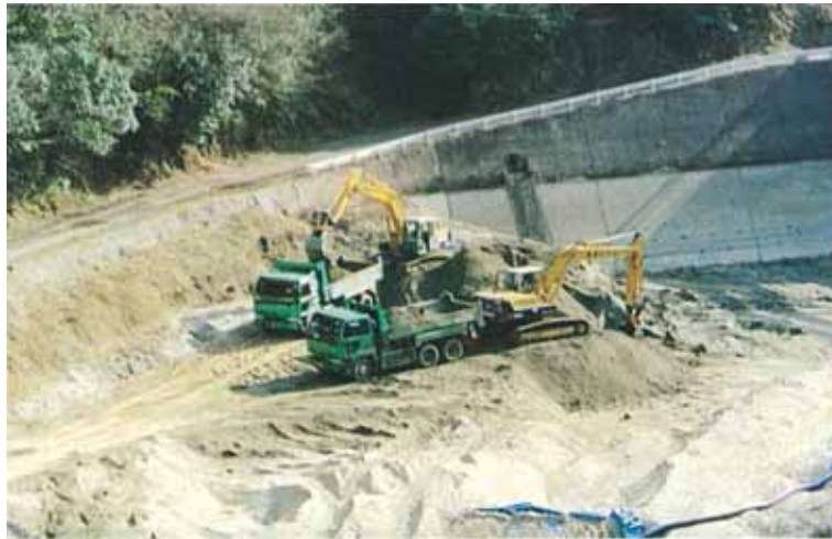
貯砂ダム内の堆砂除去状況
