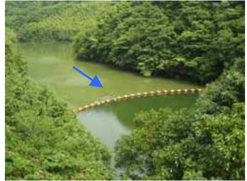
水質汚濁防止フェンス
