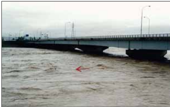
出合大橋下流の洪水流下の状況(H13.6) (松前町西高柳地先：重信川 河口より 3.3km 付近松前町側)
