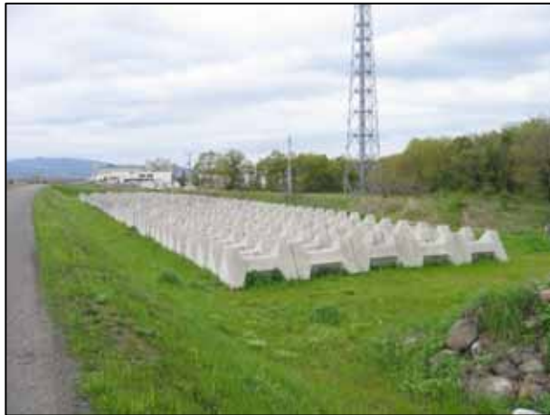
ブロック備蓄状況 (重信川 河口より 16.4km 付近 東温市北側)
