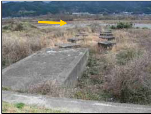
コンクリート透過水制（田窪第一水制） （重信川 河口より 15.5km 付近 東温市北側）
