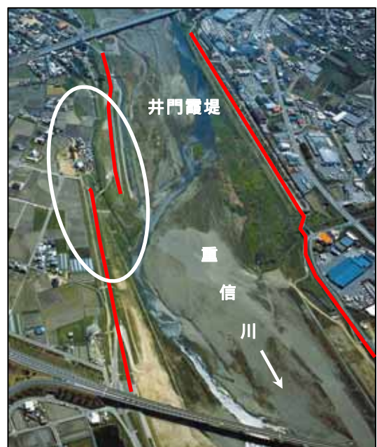
下流側上空から井門霞堤を望む
