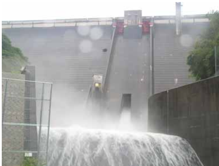
石手川ダム放流状況
