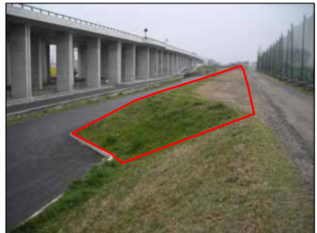
側帯整備状況 (重信川 河口より 9.6km 付近松山市側)
