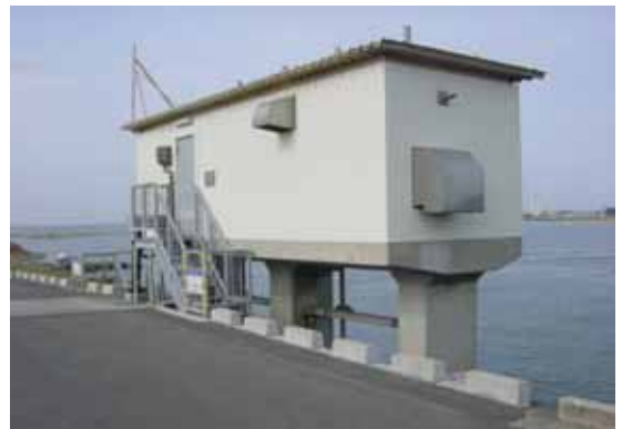
塩屋排水樋門 (重信川 河口より0.2km 付近松前町側)
