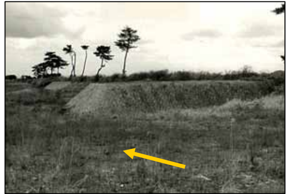
石積水制（田窪第三水制） （重信川 河口より 15.7km 付近 東温市北側）
