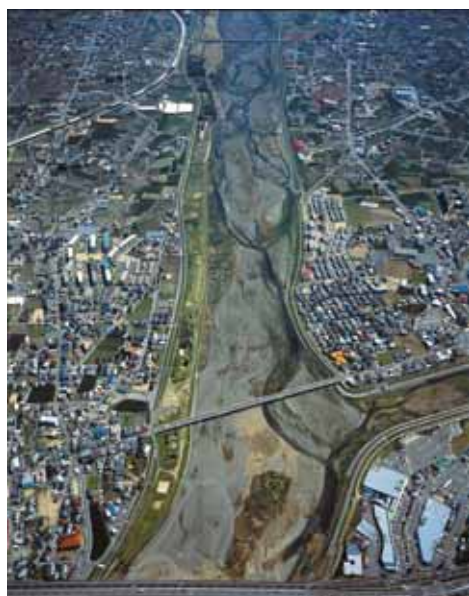
重信川中流部（重信橋付近）
