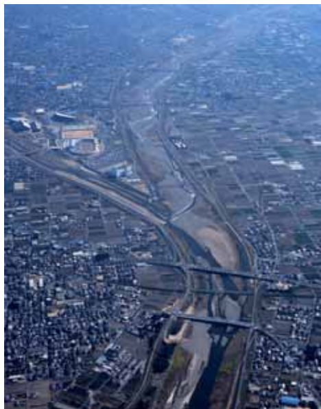
重信川下流部(石手川合流付近)
