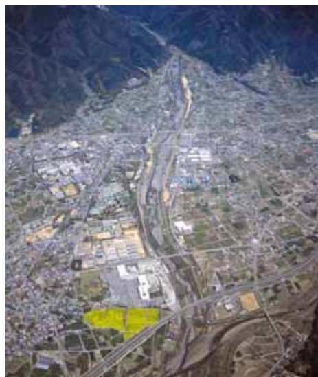
重信川上流部（四国縦断自動車道）
