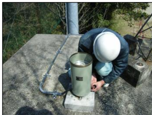
雨量観測施設点検状況
