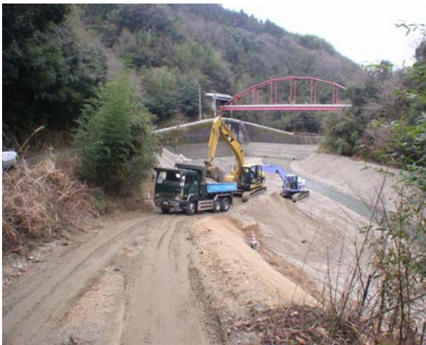
堆砂除去の状況（石手川ダム）
