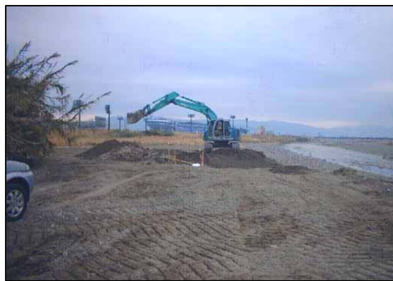
河床整正状況 (重信川 河口より4.2km付近松山市側)
